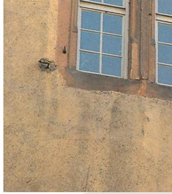
**Exterior:** Limpie las pinturas antiguas bien adheridas en seco o húmedo. Retire los recubrimientos minerales disgregados o que no presenten buena adherencia son pegajosos, mediante medios mecánicos, lijado, raspado o amolado y enjuague toda la superficie con agua de acuerdo con las regulaciones legales de aguas residuales. Imprimir con Sylitol® RapidGrund 111 (máx. 1:1 diluido con agua) según absorción del soporte. Recubrimientos finales con materiales de Sylitol® o Histolith.
