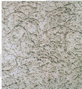
**Exterior:** Limpie los revoques antiguos con un método adecuado de acuerdo con las regulaciones legales. Con limpieza húmeda chorrear máx. a 60 bar de presión. Deje que las superficies se sequen bien antes de continuar con el tratamiento.
