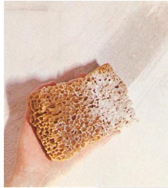
**En el interior:** Lavar completamente. Deje que las superficies se sequen bien. Imprimación: Imprimir con Dupa-Putzfestiger.
