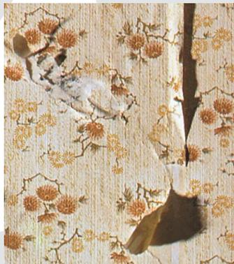
**Interior:** Eliminar del papel pintado por completo. Lijar la superficie para eliminar la cola y restos o lávelos con agua. Deje que las superficies se sequen bien. Imprimación: Con Dupa-Putzfestiger o TiefGrund TB.
