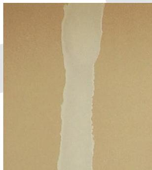
**Interior:** Lijar la masilla de juntas. Imprimir previamente con Dupa-Putzfestiger las reparaciones con masilla. Imprimación: Con Caparol HaftGrund EG, Acryl Hidrosol. Aplicar una imprimación bloqueante de manchas en placas con sustancias solubles en agua con Caparol o Filtergrund grob.
