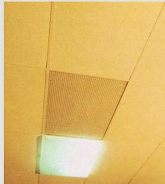
**En el interior:** Compruebe que los paneles están firmemente adheridos. Pega placas no adheridas. Imprimación: No se requiere imprimación. Para recubrir las placas contaminadas con nicotina, utilice pinturas bloqueantes de manchas IsoDeck, Aqua-inn N°1 o Dupa-inn.
