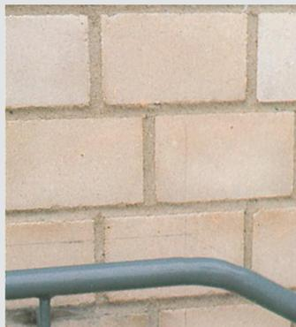
**Exterior:** Solo se pueden recubrir con pinturas en emulsión de silicato o resina de silicona. Recomendamos el uso de materiales de Sylitol® o AmphiSilan para esto.
