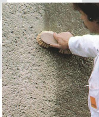
**Exterior:** Limpiar toda la superficie mediante lavado, cepillado, aplicación de agua a presión de acuerdo con las normas legales.
