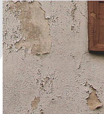
**Exterior:** Eliminación completa mediante lijado, raspado, chorro húmedo u otros métodos adecuados. En el caso de la limpieza en húmedo, deje que las superficies se sequen bien antes de continuar con el tratamiento. Imprimación: Dependiendo del sistema de recubrimiento posterior con Dupa-Putzfestiger o Syllitol®RapidGrund 111.
